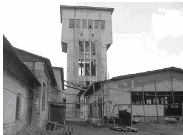
Fig. 2: Instalația de extracție „Puț Centru “E.M. Petrila
