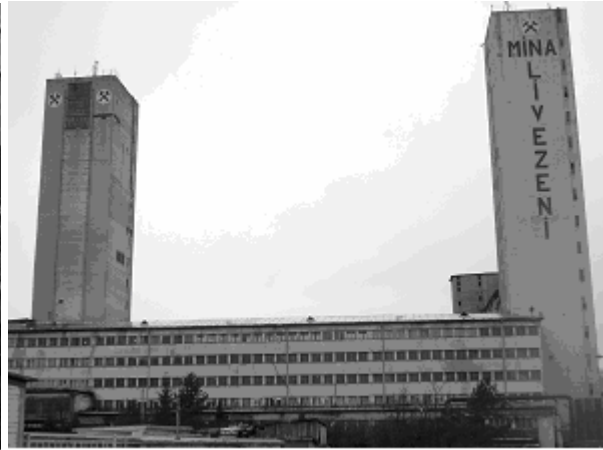
Fig. 8. Instalația de extracție „ Puț auxiliar nr.1 “ E.M. Livezeni (stânga)
