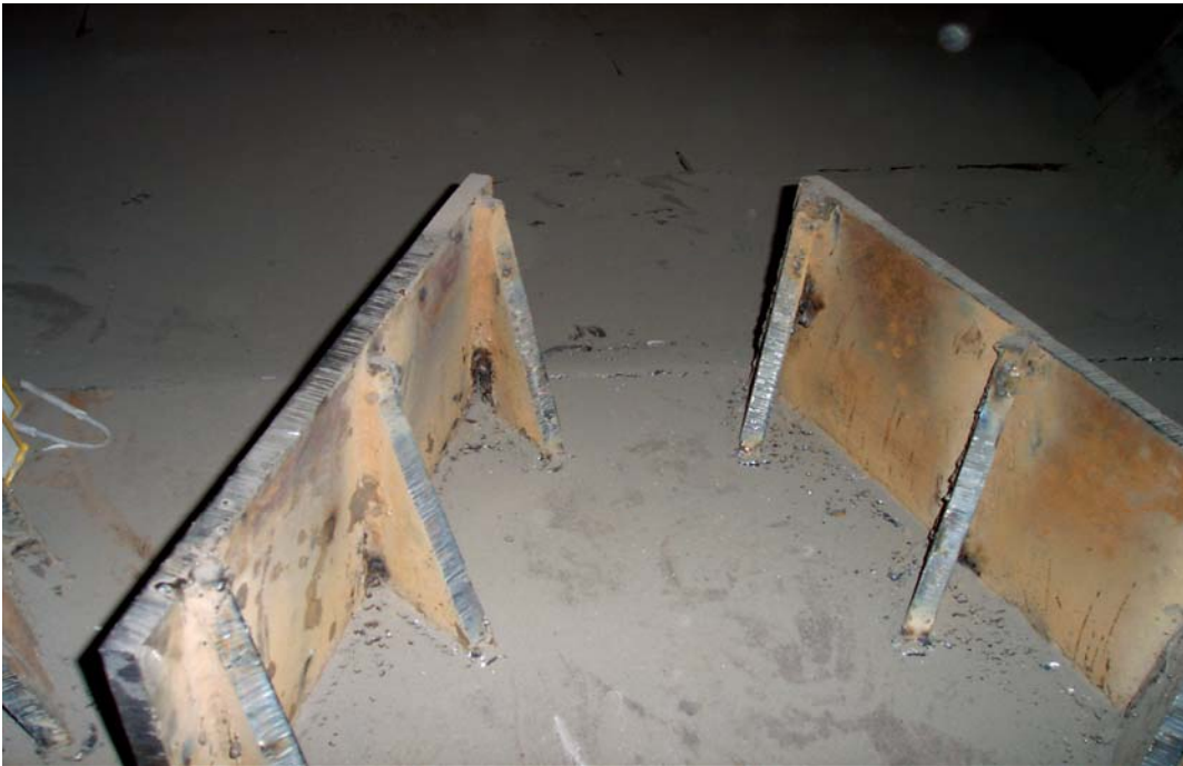
Fig. 2 – Șicane pentru dirijare a fluxului de cărbune
