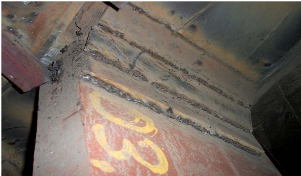
Fig. 3 – Protejarea cordonului de fixare a paleților și a zonelor adiacente
